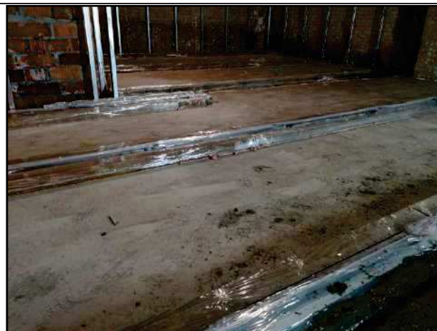
Protecció amb film de les guies abans de massissar
