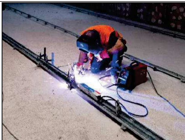
Unió de les guies amb soldadura
