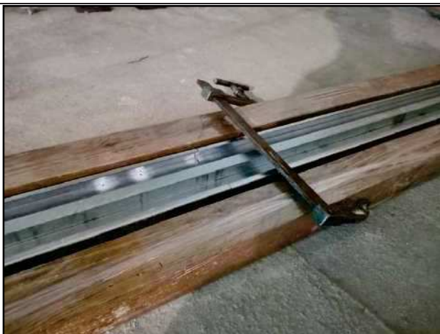
Encofrat de les guies
