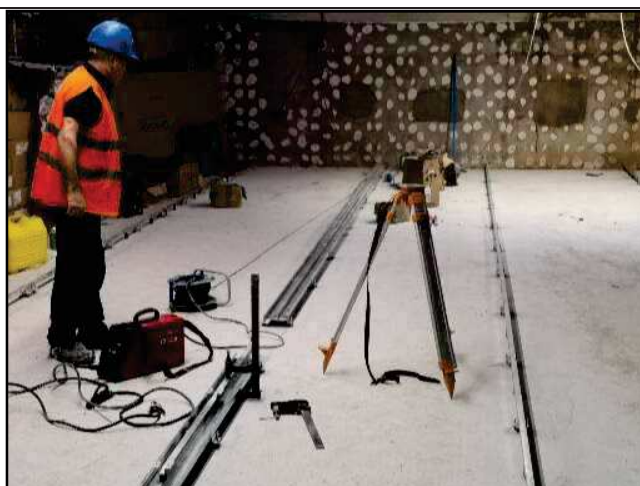
Anivellació amb nivell òptic làser
