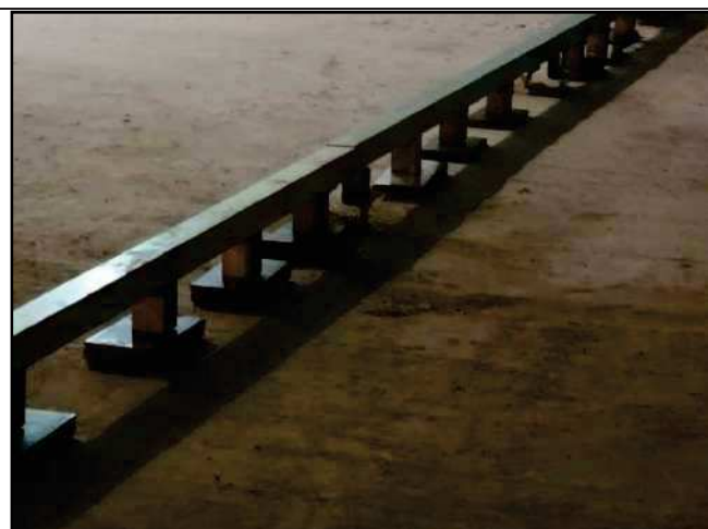
Falta mil·limètrica, per mantenir l'anivellació
